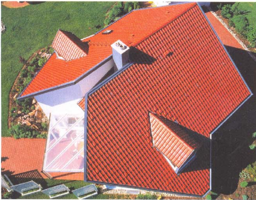
Außen hui und innen auch: Die Dämmung schützt im Winter vor Kälte und im Sommer vor Hitze.
